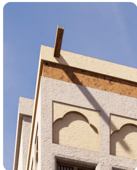
4 سترة سطح (دروة) مزينة بشرائط أفقي ذو ألوان متباينة بشكل طفيف مع المبنى.
