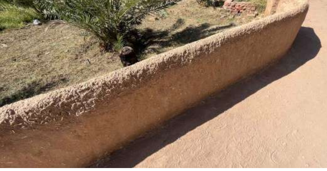
شكل 65. حوائط سائدة باستخدام المواد الطبيعية والمحلية مثل الطين. العلا، المملكة العربية السعودية.
