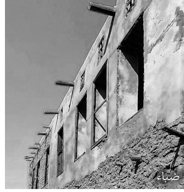
ضياء مزاريب بارزة عن الواجهة لتصريف مياه الأمطار
