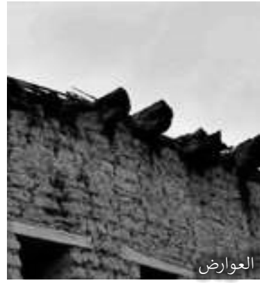
القموص عوارض لسقف تقليدي
