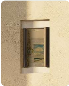
2 فتحات نوافذ بسيطة تم إبرازها باستخدام عتبات وجلسات مميزة، وسواتر خشبية مزخرفة
