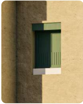
2 فتحات نوافذ بسيطة تم تمييزها بسواتر خشبية
