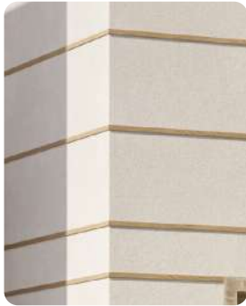
2 أحزمة أفقية وجدران مشطبة باستخدام اللياسة.
