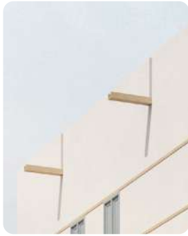
1 سترة سطح مستوية تتضمن مزاريب (عناصر تصريف مياه الأمطار) بارزة
