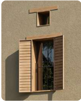
2 نوافذ باطار خشبي مزودة بسواتر خشبية وتعلوها فتحات تهوية.
