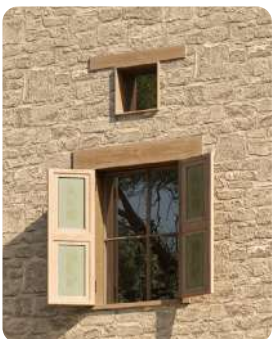
2 إطار خشبي بسيط ونوافذ مزودة بسواتر خشبية وتعلوها فتحات تهوية.
