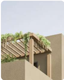
3 شرفة (بلكونة) موضوعة خلف سترة سطح (دروة) مرتفعة تعلوها مظلة.
