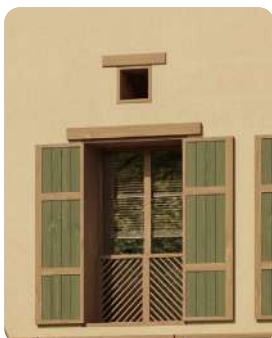
2 نوافذ بإطار خشبي مزودة بسواتر خشبية وتعلوها فتحات تهوية.
