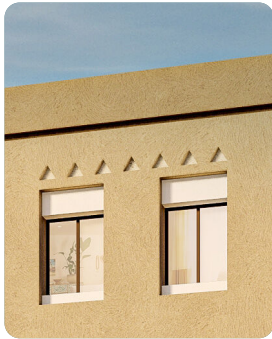
2 فتحات نوافذ تم تمييزها بعنابت وجلسات مميزة
