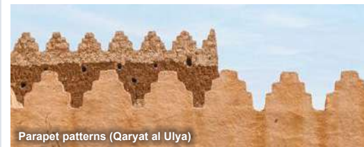
Parapet patterns (Qaryat al Ulya)
