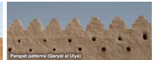
Parapet patterns (Qaryat al Ulya)
