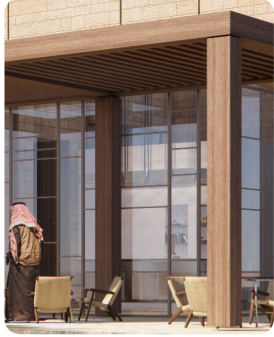
1 هيكل بارز يوفر الظل لواجهات المحلات التجارية.
