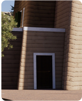
3 جدران المبنى تضيق تدريجيًا مع الارتفاع. يتميز مدخل الخدمة بأبواب مفردة محاطة بإطارات رفيعة.
